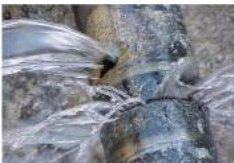
**Рис. 4.30. Потери воды на магистральном водопроводе**
